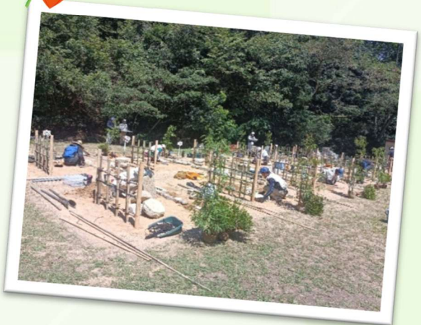
造園工事作業
